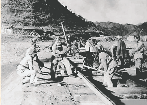
老照片记录了马寿春所在部队抢修铁路时的情景
