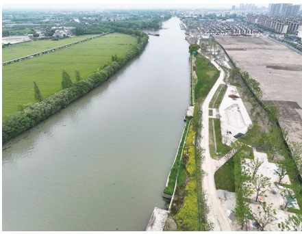
大运河国家文化公园（塘栖古镇核心段）施工现场
