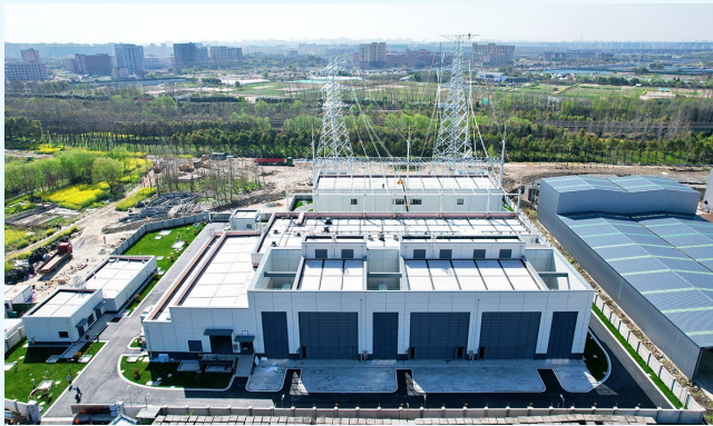
220千伏大井变投产
