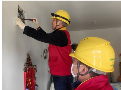
“为爱充电”慈善活动中,供电员工开展义务排查线路、电器、开关等设备
