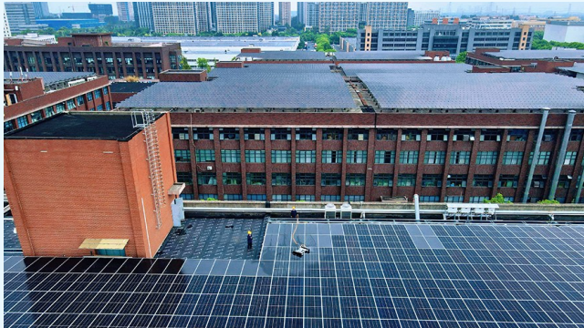
供电员工在用光伏清洗机器人清洁企业光伏板
