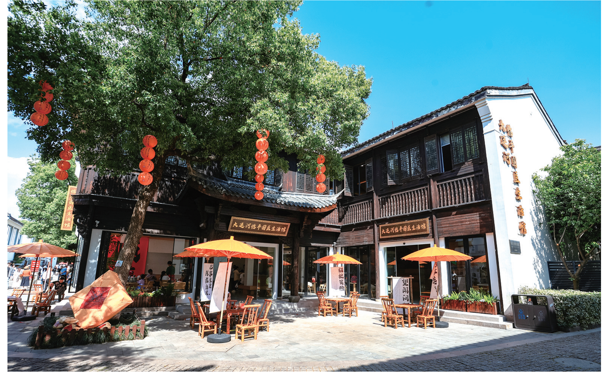
建设大运河临平国医生活馆
