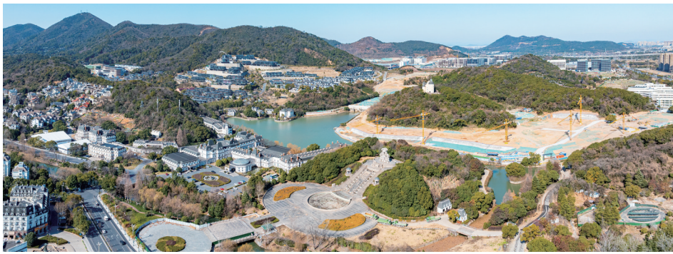
杭州方兴渡微度假文旅综合体项目正在建设中
