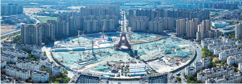
天都里项目正在建设中
