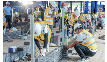
临平区“沈括杯”砌筑工技能大赛现场
